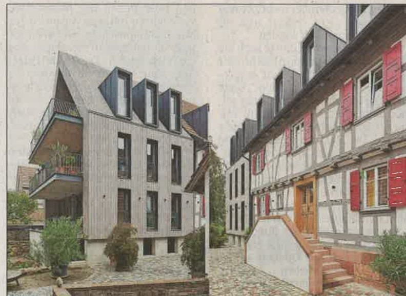
Umbau, Sanierung und Anbau eines denkmalgeschützten Fachwerkhouses in Kandel.
