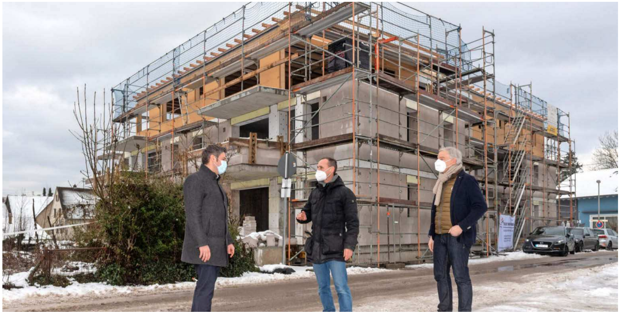
Bürgermeister Andreas Vierling tauscht sich mit Oliver Boger und Dr. Thomas Hauer (v.l.) an der Baustelle in der Zeppelinstraße über das Projekt „Eigene Haustür, gemeinsames Dach“ aus.
