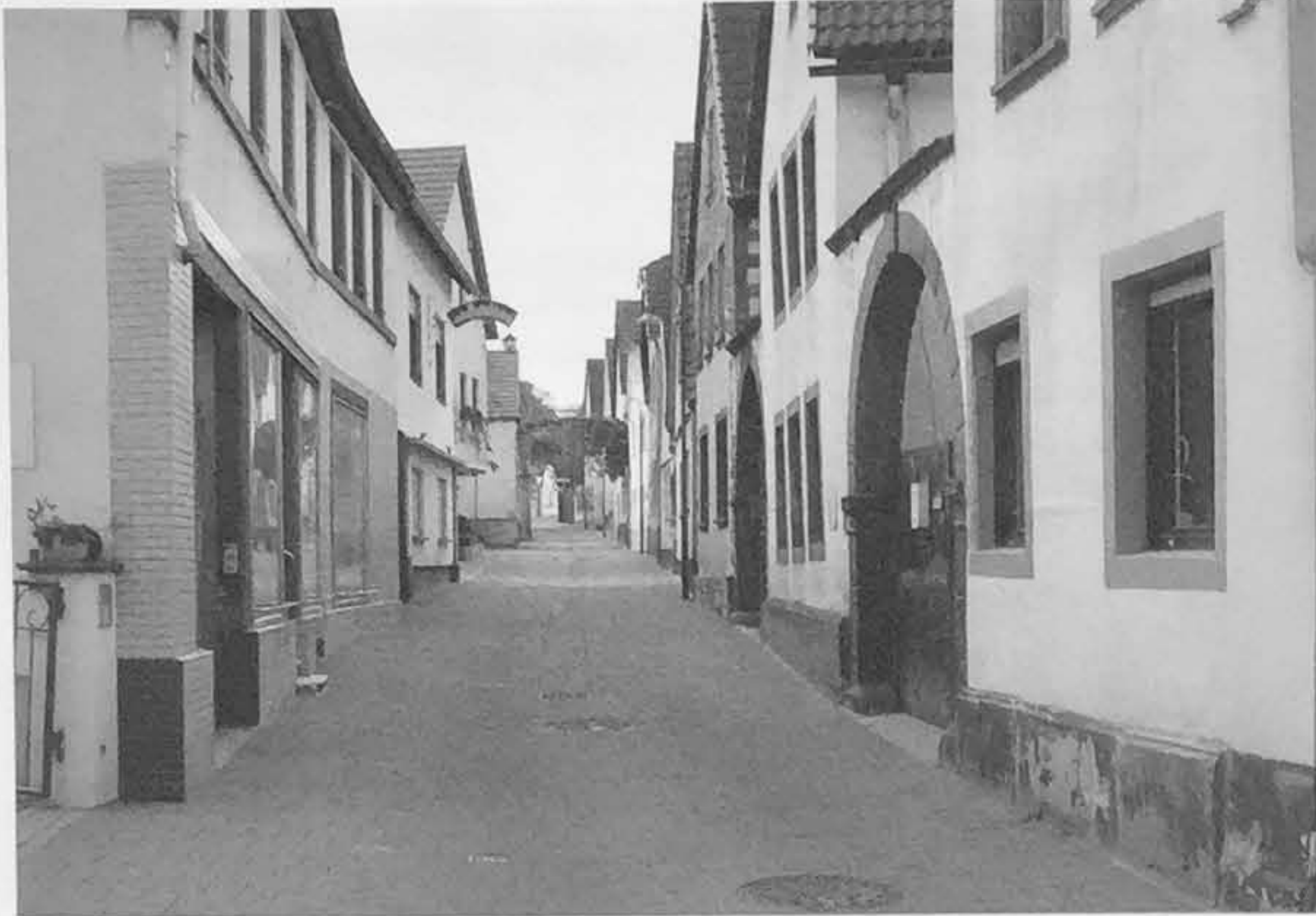
Die Rhodter Straße in neuem Glanz.
